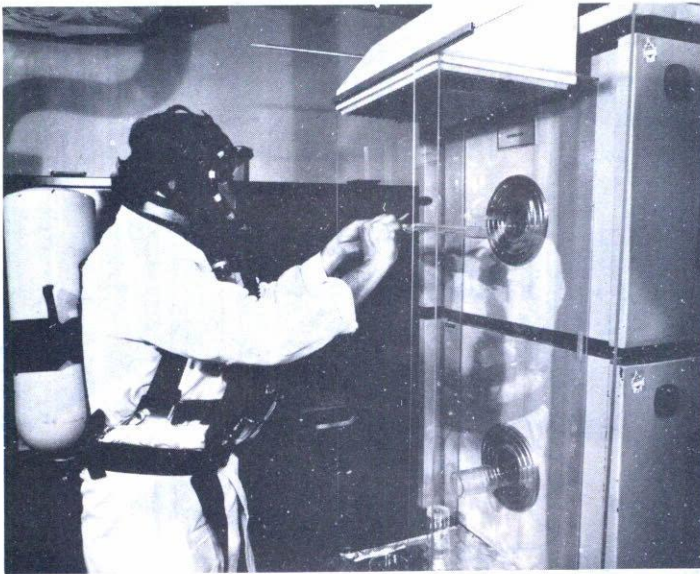
Fig. 19. Proceso de difusión de impurezas en obleas de silicio. Normalmente, se hacen dos pasos: Predepósito y Redistribución. Los parámetros de diseño a controlar son tiempo, temperatura y flujo de gases. Estos gases, (Diborano y Fosfina) son altamente tóxicos; de ahí la necesidad de utilizar un equipo de oxígeno para protección del operador.
